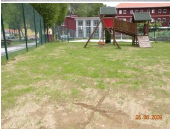
Prekritje tal s čisto zemljo in naknadna zatravitev
